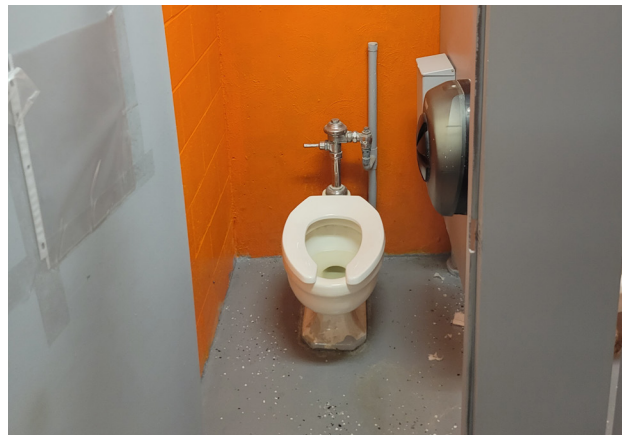
Fig. 3.4.72: Lower Level Toilet, 2023.
